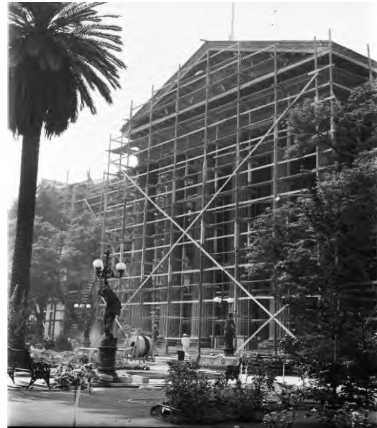
Imagen N° 41 Reparación de daños Sismo de 1960
