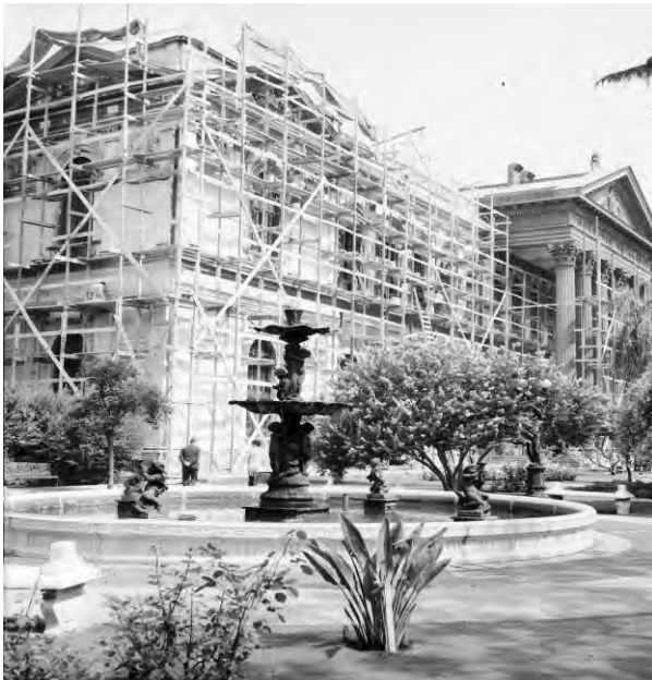
Imagen N° 40 Reparación de daños Sismo de 1960
