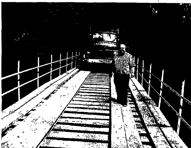
Puente reconstruido por Fuerza, Garra y Corazón SADP en Diciembre de 2011.
