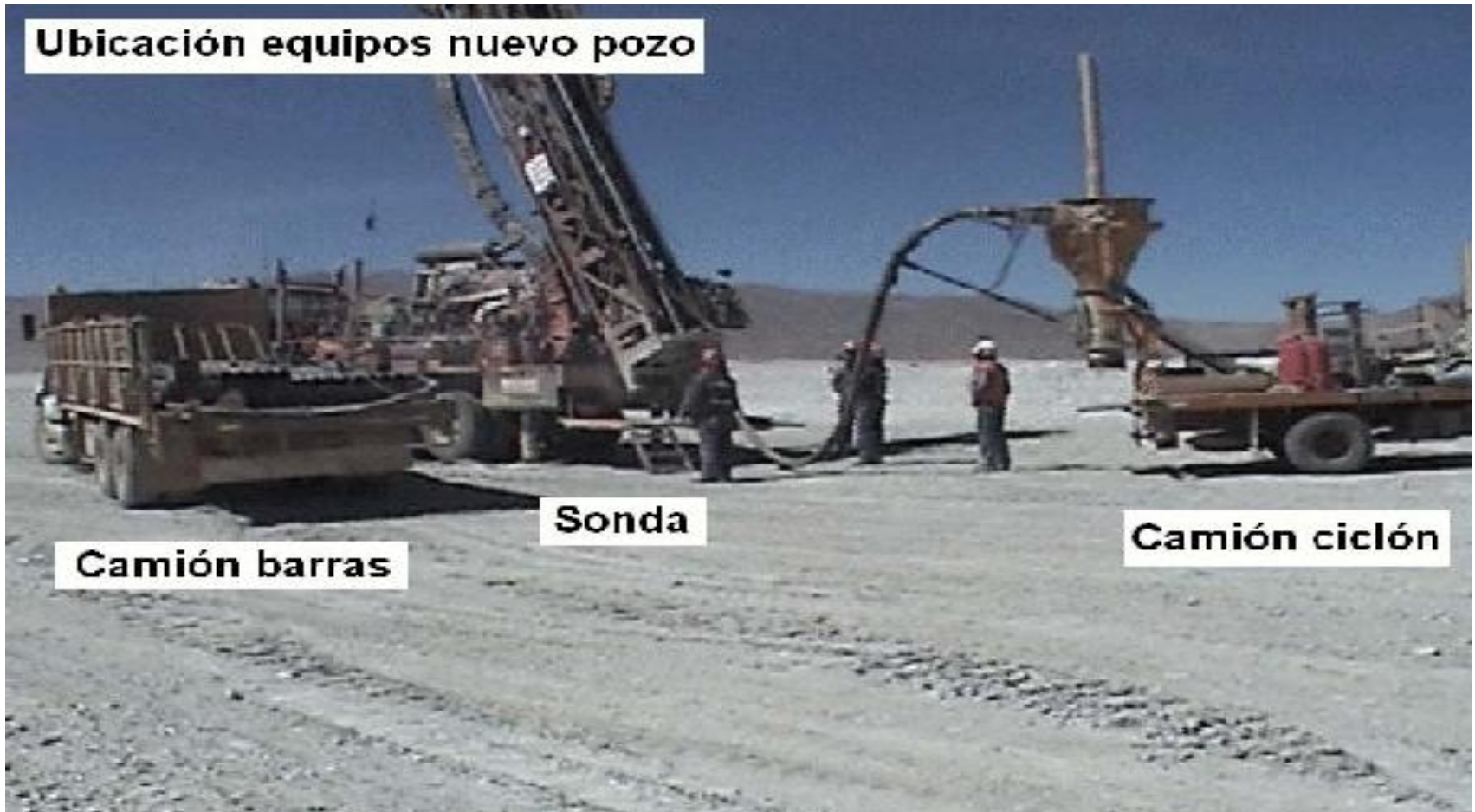
Figura 2: Plataforma de Operaciones y maquinaria instalada.
