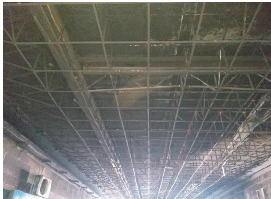
Estructura metálica del cielo
