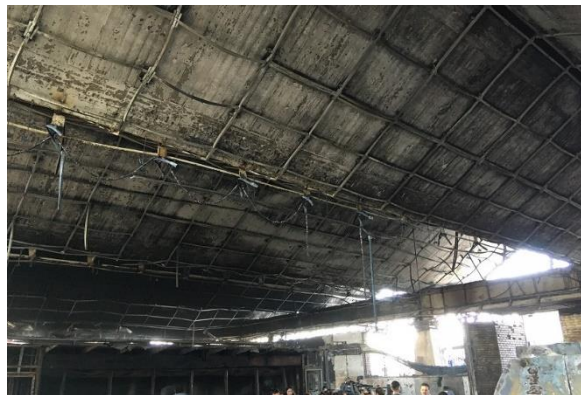
Cielo Falso estación
