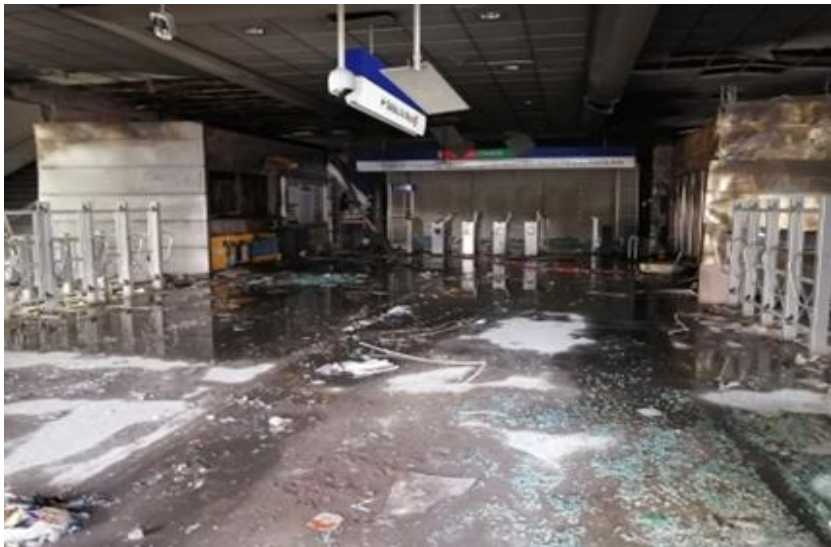
Vista general nivel mesanina
