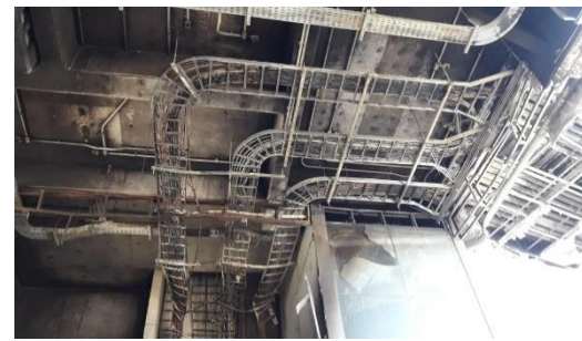
Cableado boletería – puente – sala técnica
