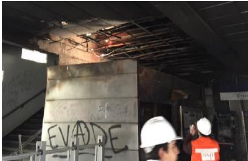
Cielo falso y estructura de soporte.
