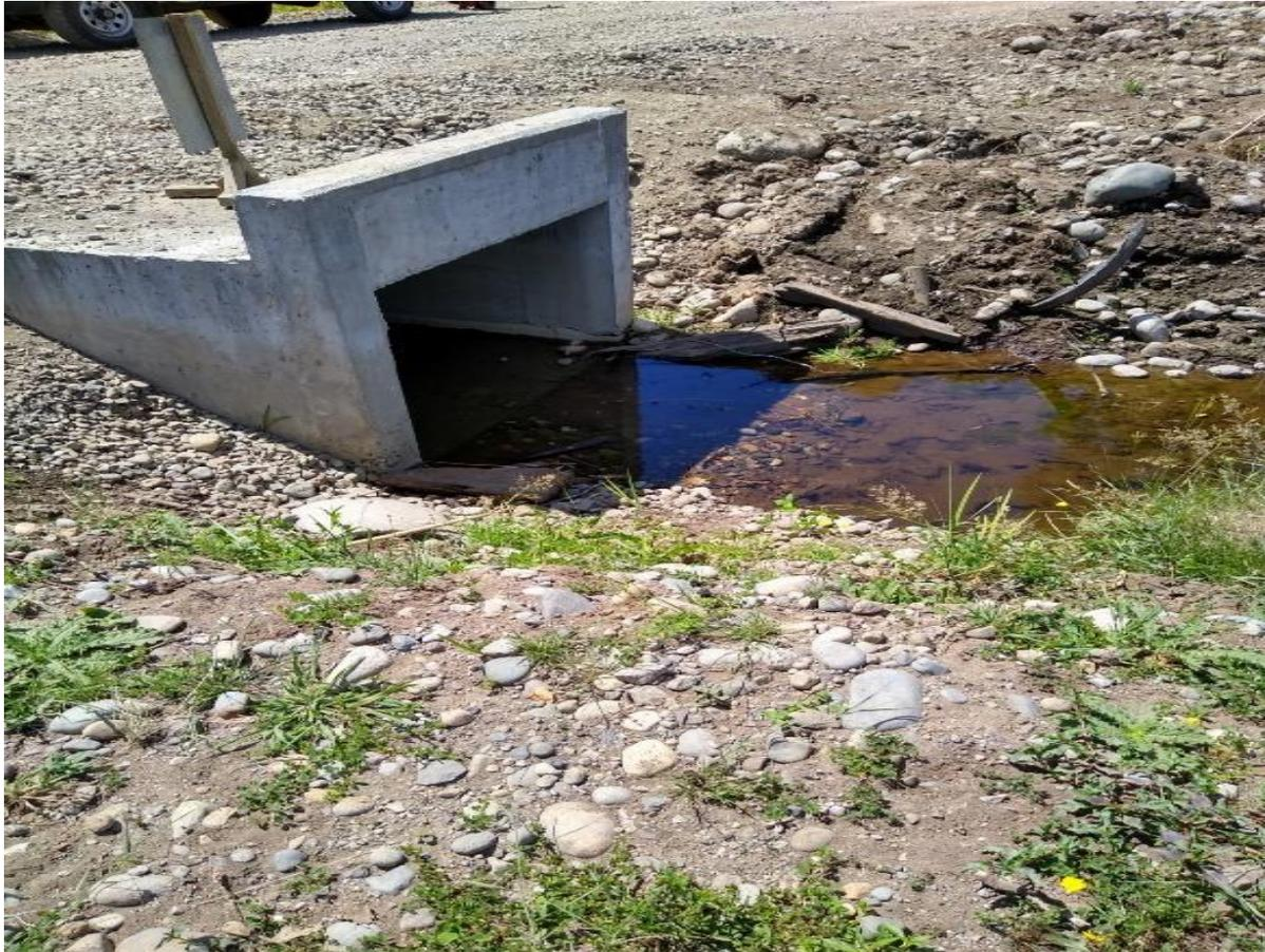
Cajón de hormigón armado incorporado en la modificación de obras.
