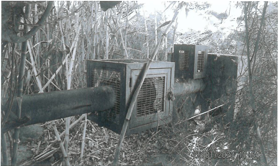
Fotografía N°5: Vista del estado de las instalaciones asociadas a la tubería y caudalímetro instalados sistema de captación de aguas no autorizado, en la ribera izquierda del Estero Derecho.
