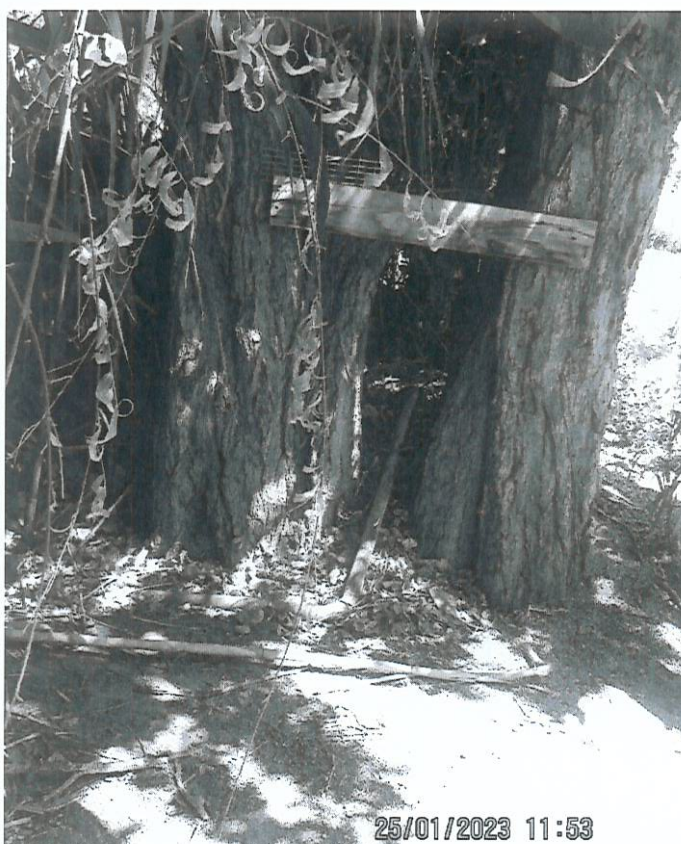
Fotografía N°2: Vista del del lugar en donde se encontraba la caseta y el tablero eléctrico y la conexión a tubería metálica, ubicada en la ribera izquierda del Estero Derecho, se aprecia el retiro del tablero eléctrico y la caseta.
