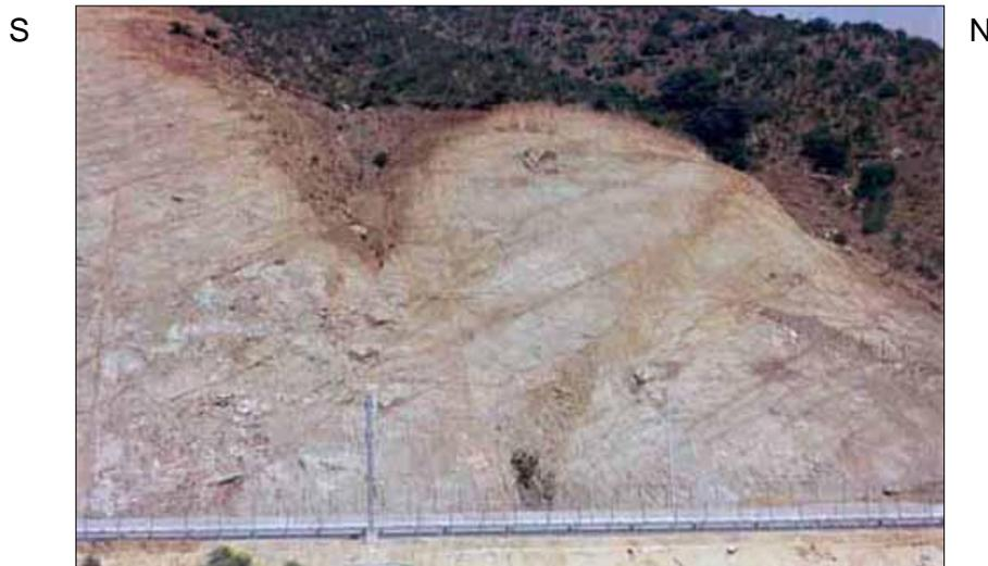
Figura 5. Fallas normales en talud de ruta Troncal Sur. En el costado sur falla N85°E/45°N y en el costado norte falla N85°W/50°S.
