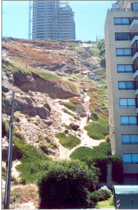
Figura 9. Talud costero en camino Reñaca-Concón en que se observa caída de bloques de roca y deslizamientos de arena.
