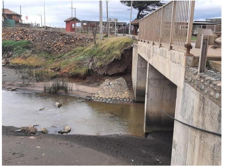
Foto 6: Daño en talud revestido con mampostería.
