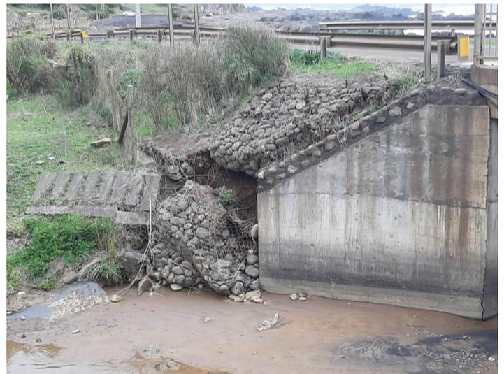
Fotos 9 y 10: Daño en gaviones de protección de talud.
