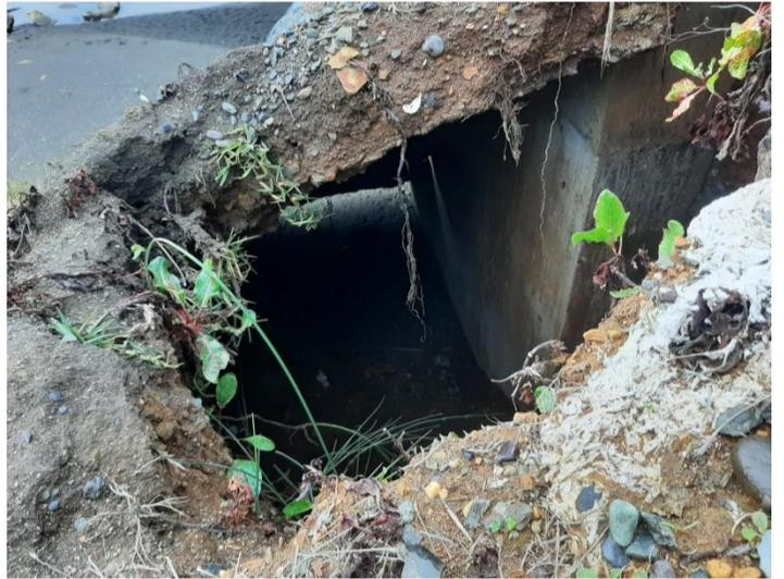
Fotos 7 y 8: Daño en talud revestido con mampostería.
