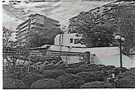
Vista lateral (deslinde norte)
