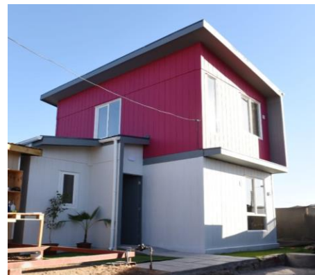
Reconstrucción Incendio Viña del Mar, Región de Valparaíso.
