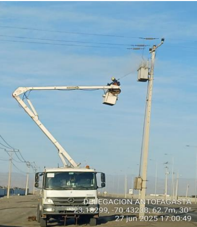
Lavado de aislación 364 Estructuras
