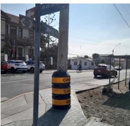
Instalación de Protectores de postes 50 Protecciones
