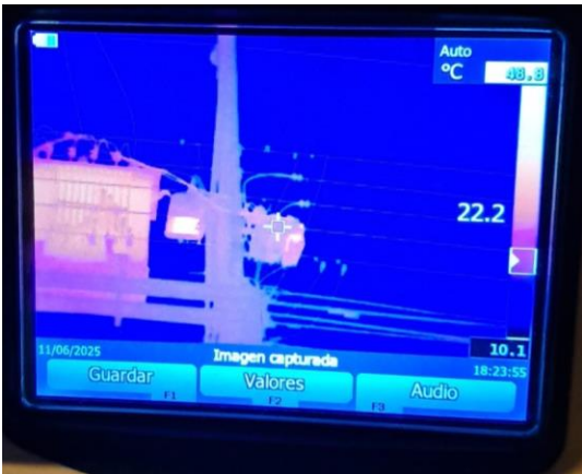
Inspección Termográfica 82 Estructuras
