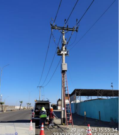
Instalación de Telemando en 8 Reconectadores
