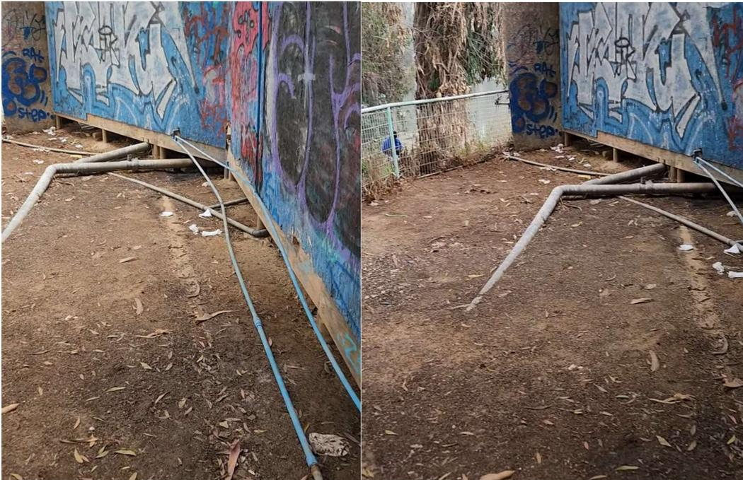
Se aprecia conexión de alcantarillado, que al parecer, estaría fuera de norma.
