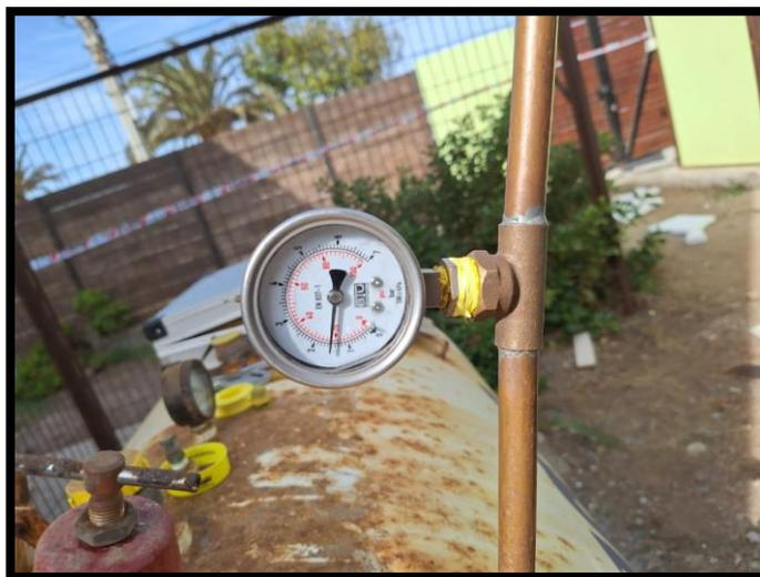
**VIII. Cilindro de 45 kilos instalado en red de baja presión.**
