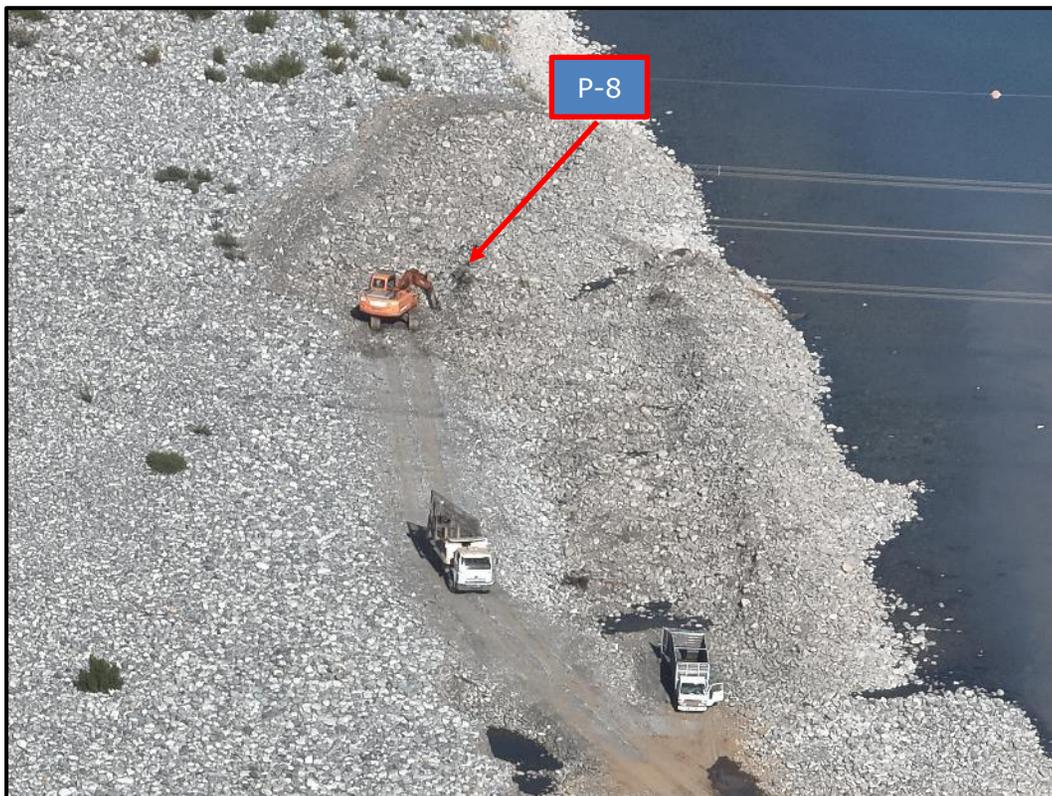
**Fotografía N°13.** Labores de extracción mecanizada de áridos en punto P-8.
