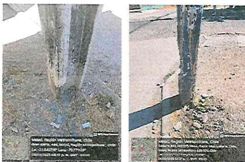
En virtud de lo anteriormente señalado, y de acuerdo con lo verificado en terreno, postes de alumbrado público, se encuentran chocado de su base, con evidente peligro de accidente, razón por la cual se solicita a Ud. canalizar, con la Unidad que corresponda, factibilidad cambio por ser propiedad y materia de vuestra competencia. Agradeceré informar resolución para dar respuesta a Unidad solicitante. Se adjuntan fotografía que avalan lo solicitado.
