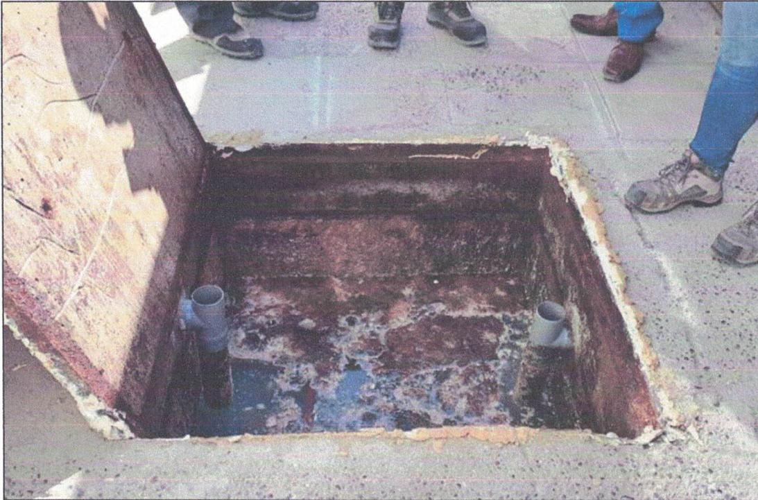
Figura N° 13 – Cámara Desgrasadora – Liceo Manuel Blanco Encalada: Vista del interior de la cámara.
