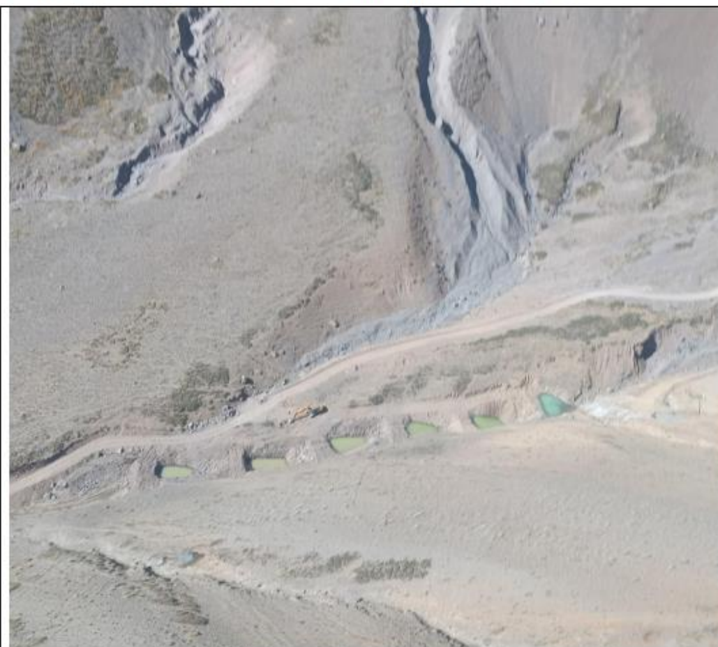
Fotografía aérea tomada el 4 de septiembre de 2023, "Pozo N°3, Pozo N°4, Pozo N°5, Pozo N°6, Pozo N°7 y Pozo N°8". Intervención cause del Estero Potrero Alto.
