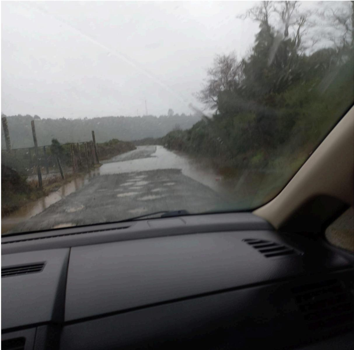
Zona más problemática con estancamiento de aguas lluvias que cortan la ruta, tanto por cunetas prácticamente inexistentes, como por desplazamiento del suelo por erosión hídrica que generó un bache de gran profundidad en el centro.
