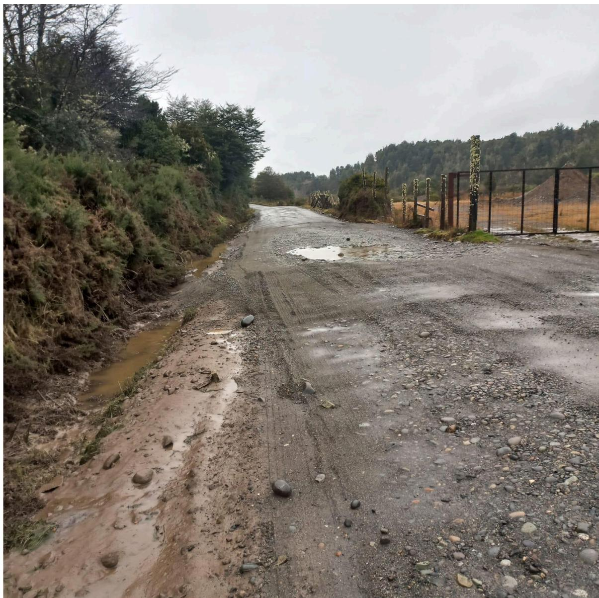
Zona más problemática, luego de dos semanas sin lluvias, se aprecia el desplazamiento del suelo que generó el bache y la inexistencia de una zanja de drenaje (cuneta).
