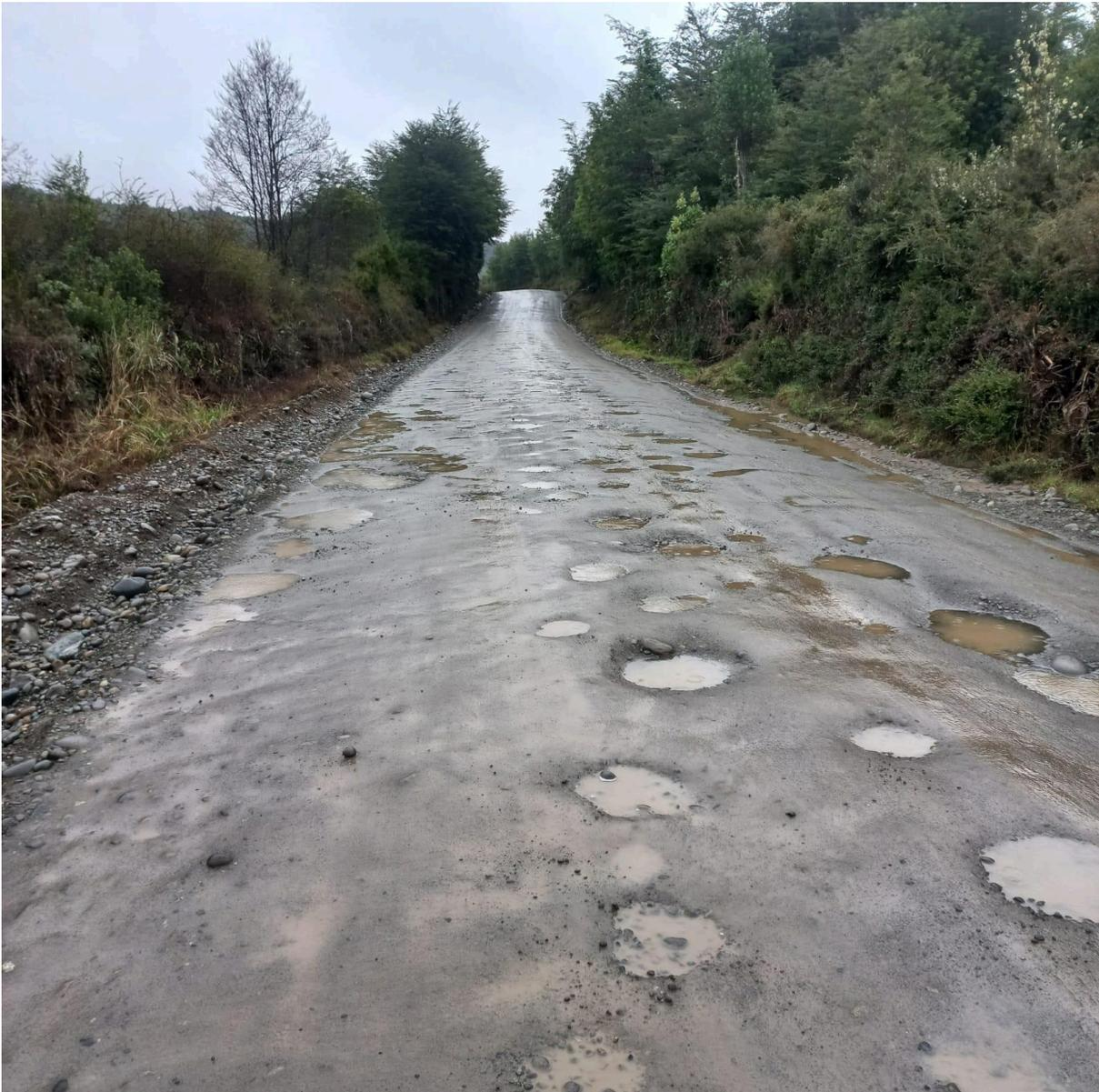
Imagen de baches superficiales por aguas lluvias de 2 días de leves precipitaciones.
