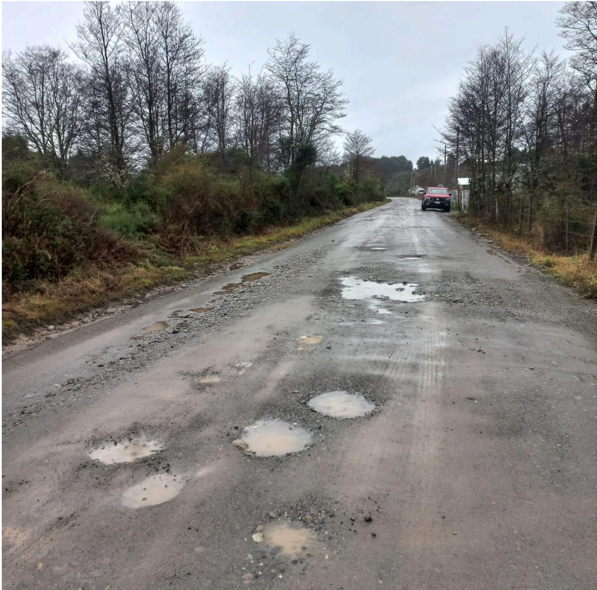
Imagen de segunda zona problemática, con dos días de leves precipitaciones. Desnivel del suelo que genera un bache en el centro. Inexistencia de zanja de drenaje (cuneta).
