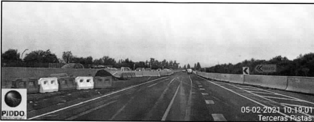
Foto 9: Tramo 2.2, calzada derecha, (Dm 19+300 al Dm 22+200)
