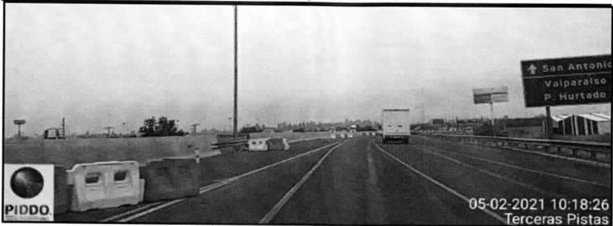
Foto 8: Tramo 2.2, calzada derecha, (Dm 19+300 al Dm 22+200)
