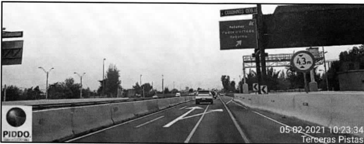
Foto 12: Tramo 2.4, calzada derecha, (Dm 25+500 al Dm 28+800).
