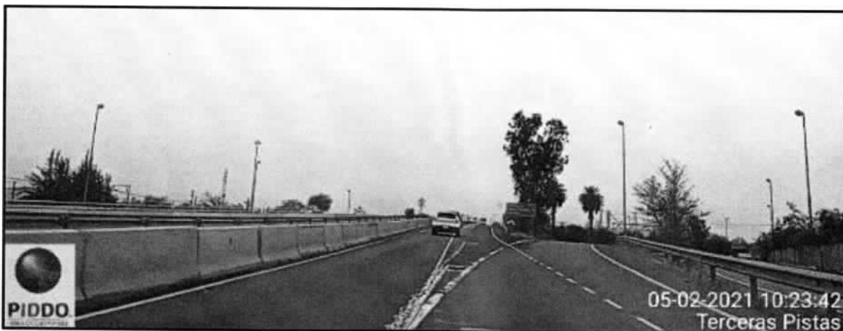
Foto 13: Tramo 2.4, calzada derecha, (Dm 25+500 al Dm 28+800).
