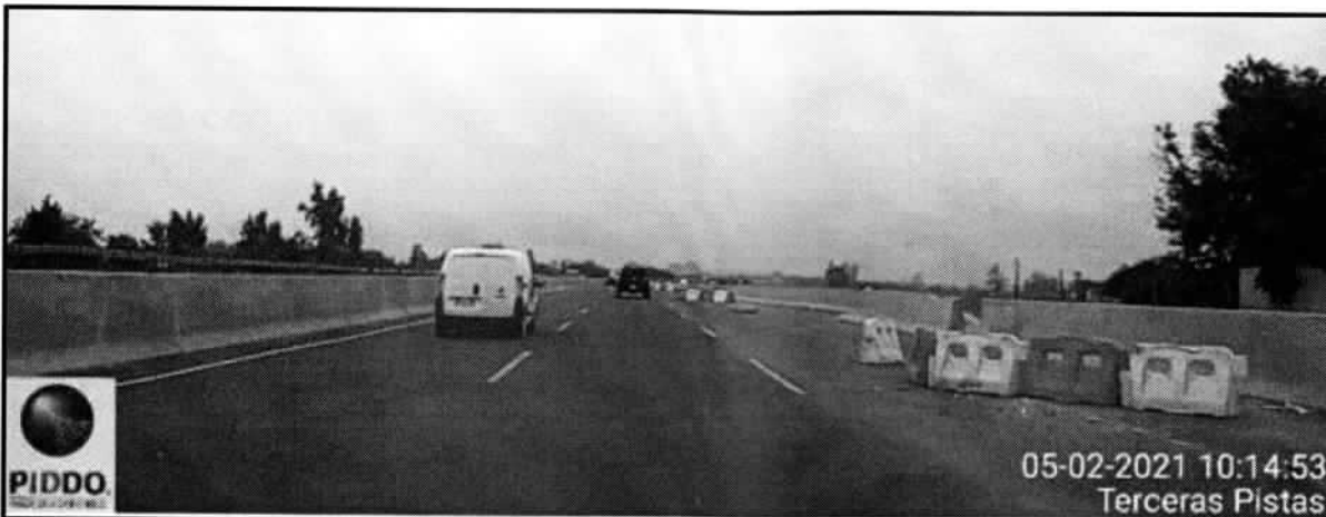
Foto 1: Tramo 2.1, calzada derecha, (Dm 16+000 al Dm 19+300)
