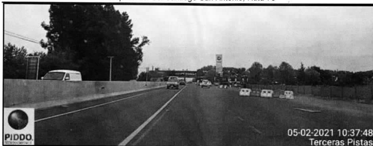
Foto 14: Tramo 3.1, sector COPEC, calzada izquierda, (Dm 31+200)
