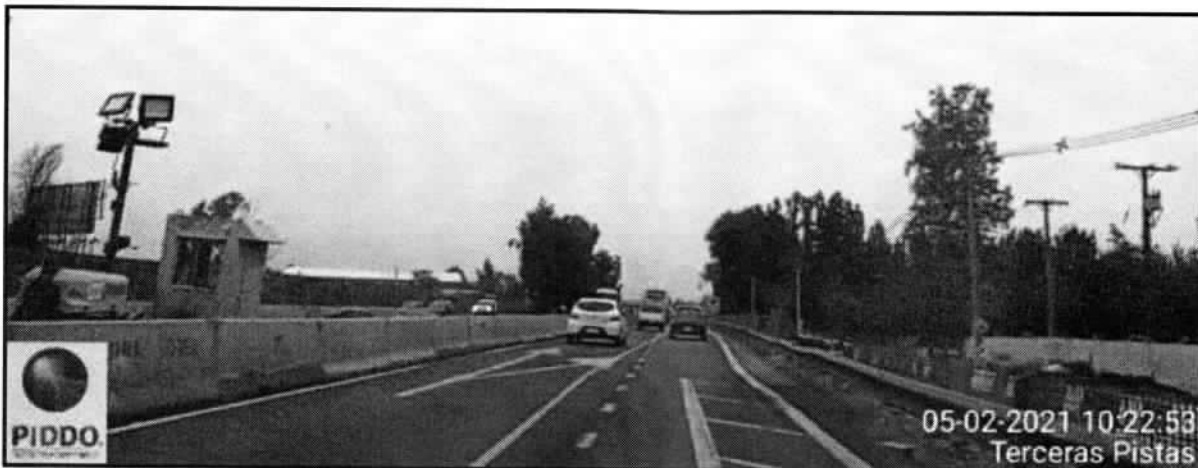
Foto 10: Tramo 2.4, calzada derecha, (Dm 25+500 al Dm 28+800).
