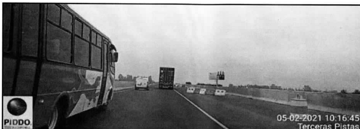
Foto 7: Tramo 2.1, calzada derecha, (Dm 16+000 al Dm 19+300)
