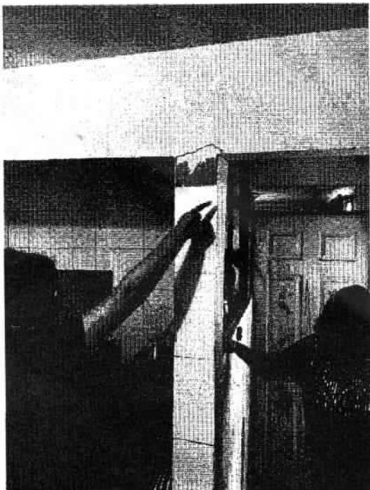
Fisuras en diagonal y escalonada, en muro de bloques de hormigón del patio trasero
