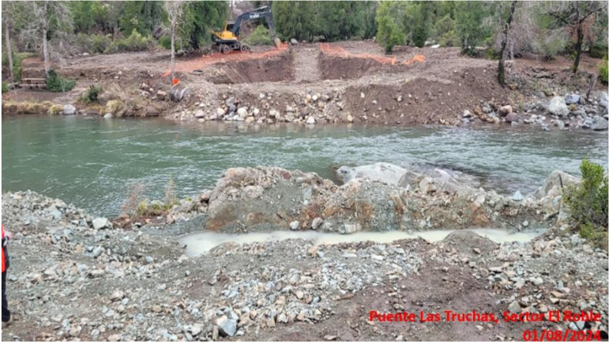
Excavación de los estribos puente Las Truchas, Sector El Roble.
