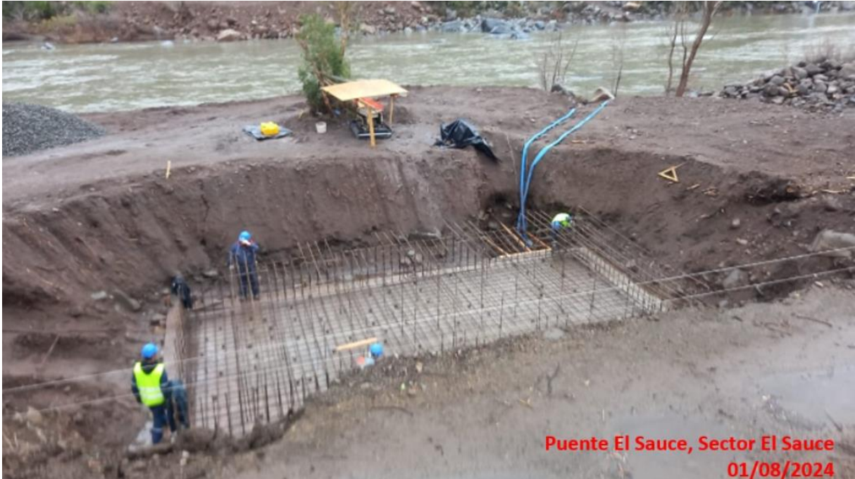
Enfierradura estribos del puente El Sauce.
