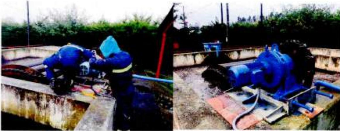
1.- Mantenimiento y cambio de componentes del motorreductor, cambio de engranajes, engrase de piezas y cambio de aceite adecuado. Para realizar este cambio fue necesario diseñar un sistema de bombeo de aire para continuar con la oxigenación del proceso, con esto dar continuidad de operación mientras se realizaba la mantención.
