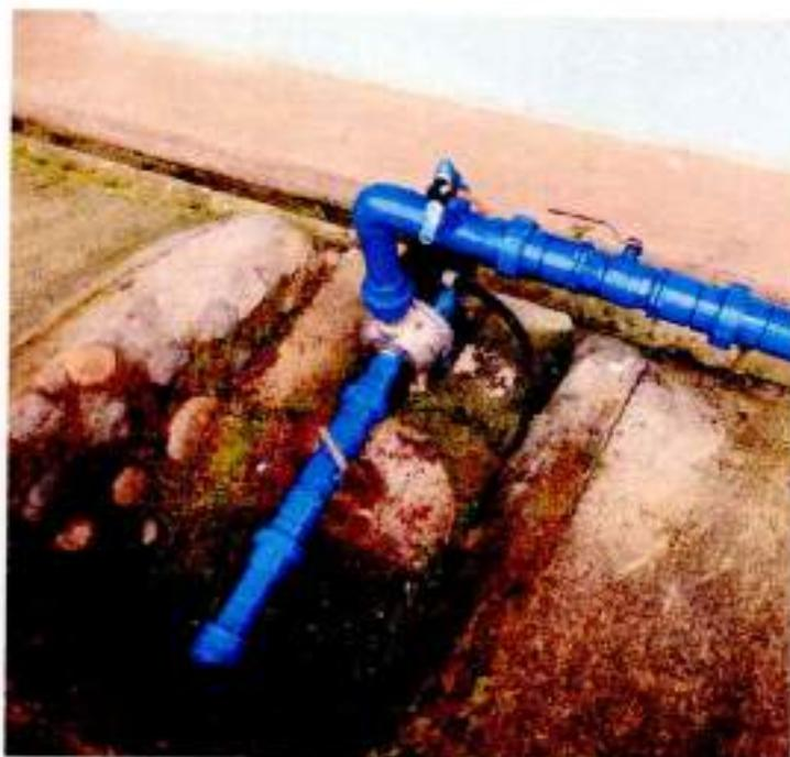
2.- Mantenimiento a bomba de lodos, la finalidad de este equipo es trasladar el lodo desde el reactor hasta las piscinas de secado.
