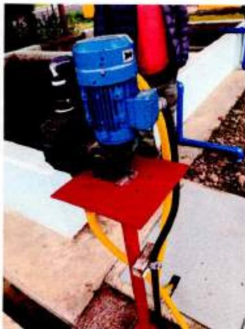
3.- Mantenimiento a bomba de polímero y cambio de mangueras, este equipo cumple la finalidad de inyectar un producto químico que ayuda a deshidratar el lodo y encapsular olores, su mal funcionamiento repercute en la mala homogeneización del polímero al interior de la piscina.
